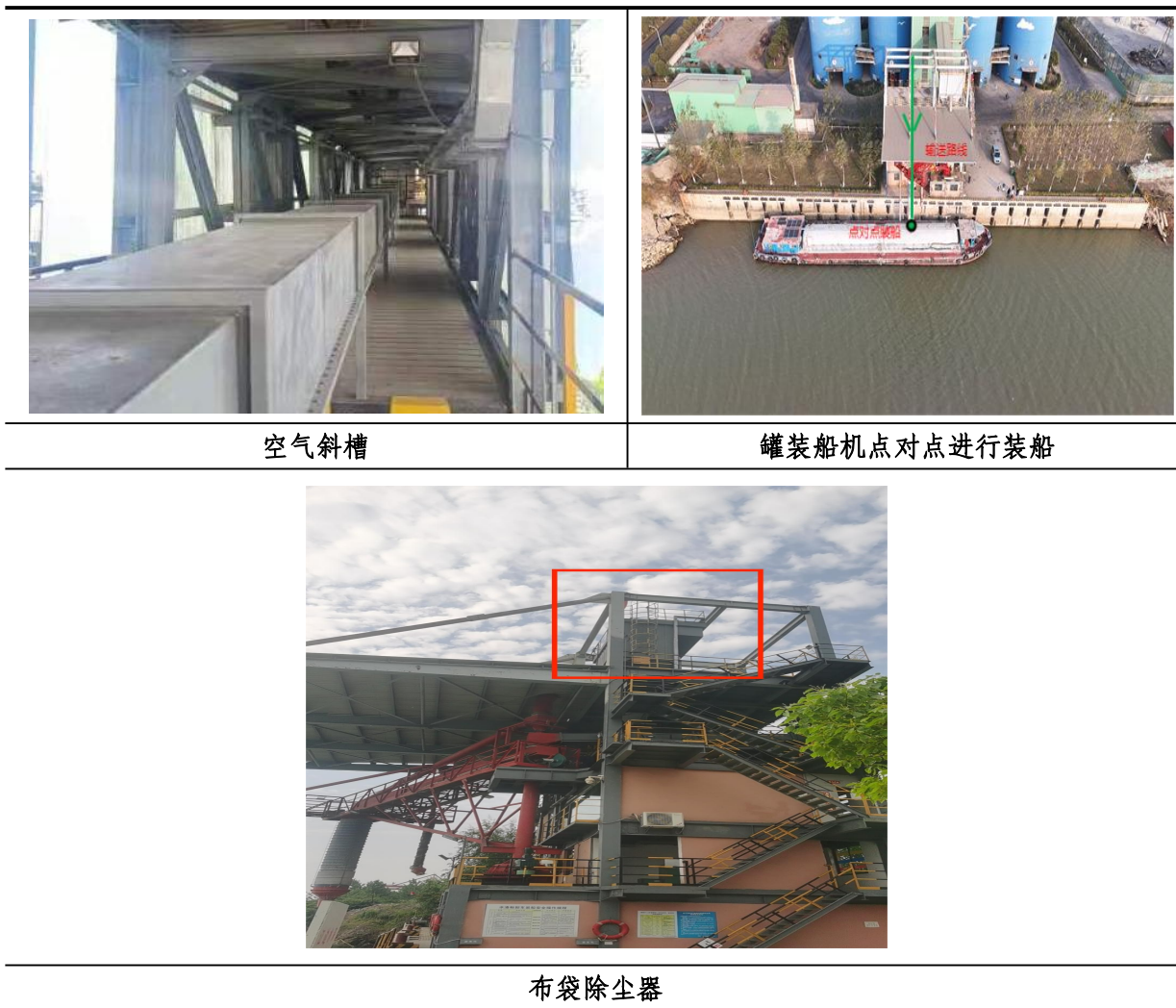
图 3.9-1 1#康迪斯成品库延伸码头现场照片
