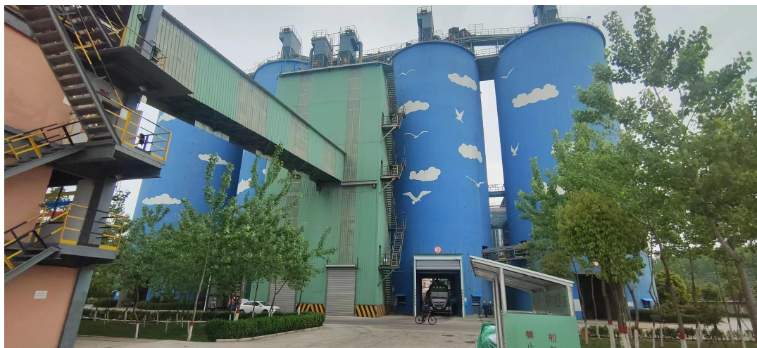
图 3.2-1 1#康迪斯成品库延伸码头矿渣微粉成品仓筒
