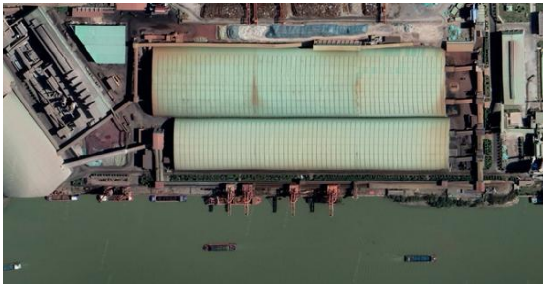
图 3.4-16 2#恒润原料码头现状
