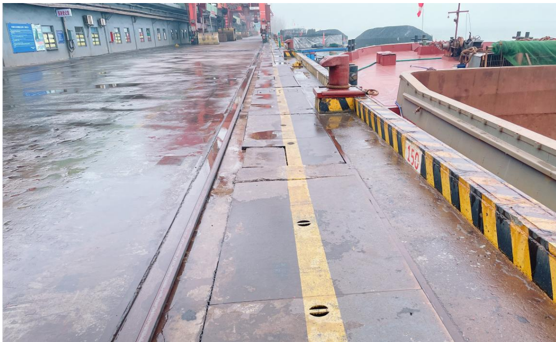
图 3.4-17 2#恒润原料码头废水收集管道
