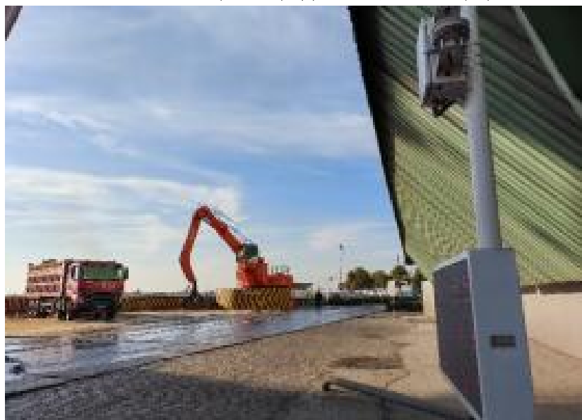
图 3.4-18 2#恒润原料码头在线监测设备
