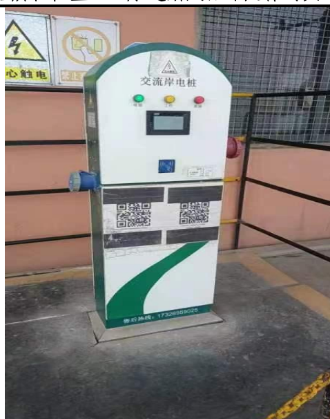
图3.4-3 1#康迪斯成品库延伸码头岸电桩
