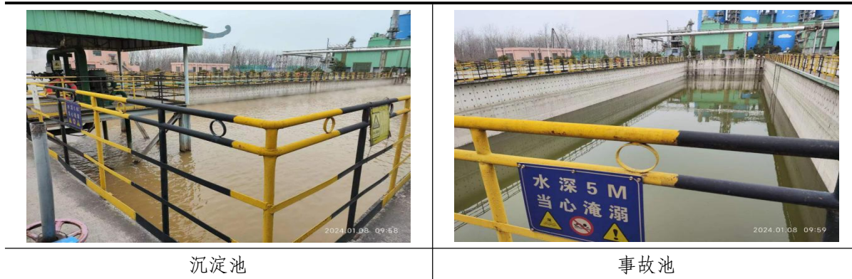
图 3.3-3 企业现场沉淀池、事故池建设情况
