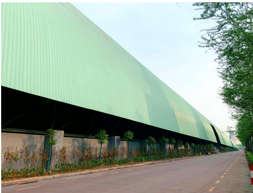
图 3.2-2 2#恒润原料码头原料仓库照片
