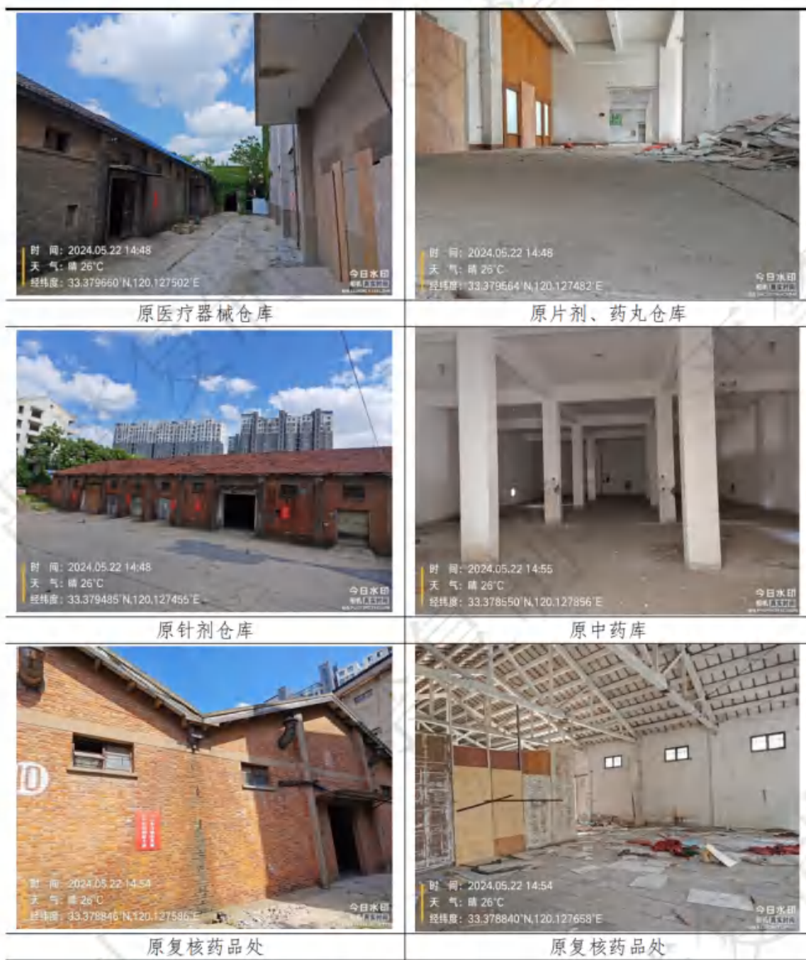
图 3.4-1 现场踏勘照片
