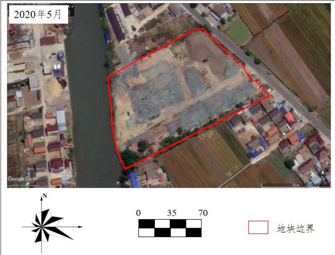
摄于 2020 年 5 月（地块内构筑物已全部拆除）
