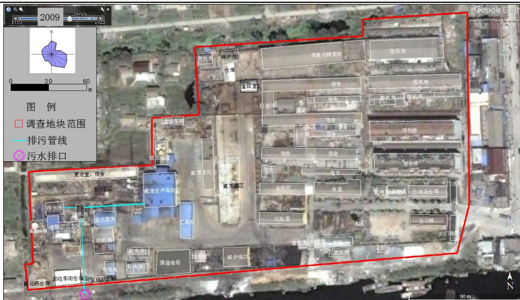
2009 年历史影像，地块西部主要为主要生产区域，包括氟苯生产车间、废酸回收车间、冰机房等，东部则主要为居民楼，食堂、办公室等非重点区域，北侧氟化钾车间区域已闲置
