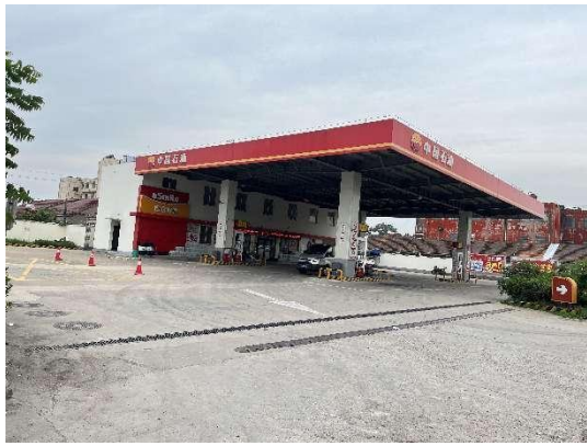
中国石油（射阳城西加油站）
