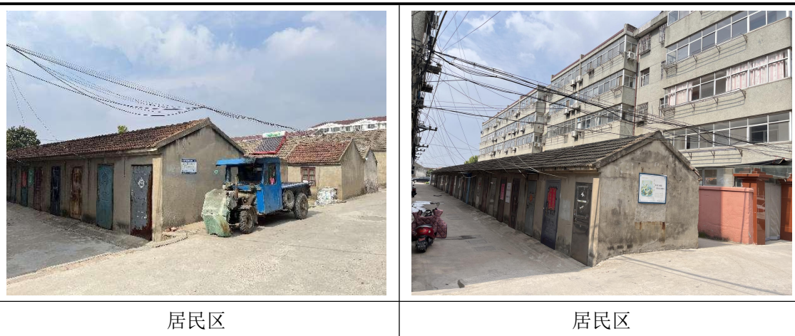
图 4.2.1-2 地块内现存构筑物照片
