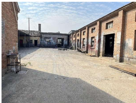
原双龙造船厂维修车间
