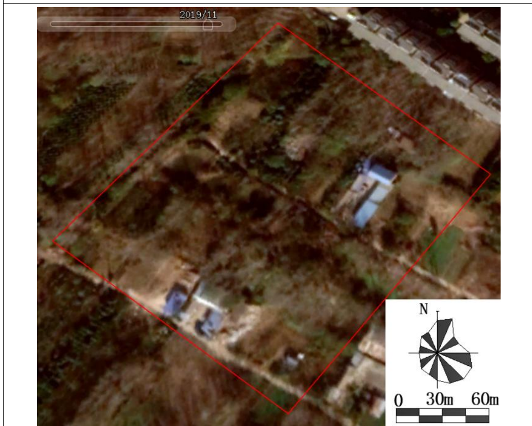
摄于 2019 年 11 月（两处居民房没拆除，其余居民房已全部拆除，地块内西侧水塘用宅基地地基土填平，其他基本无变化）
