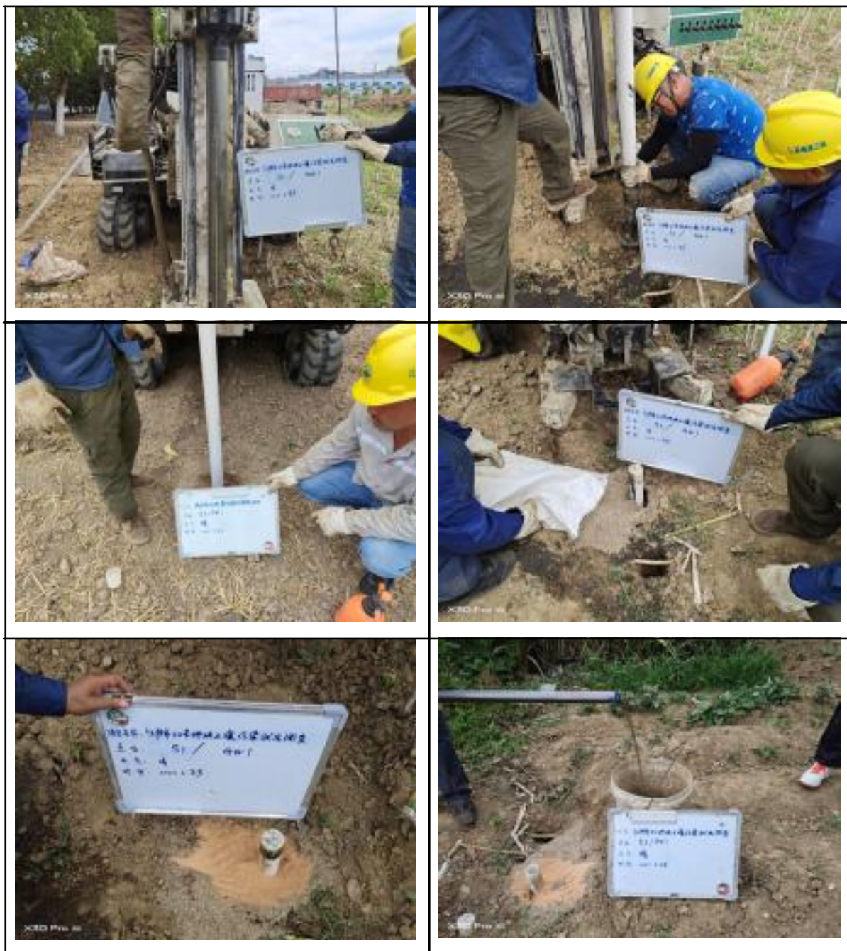
图 5.2.14 地下水监测井建设
