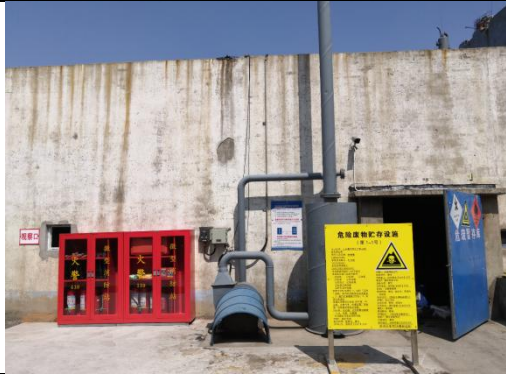
危险废物暂存场所
