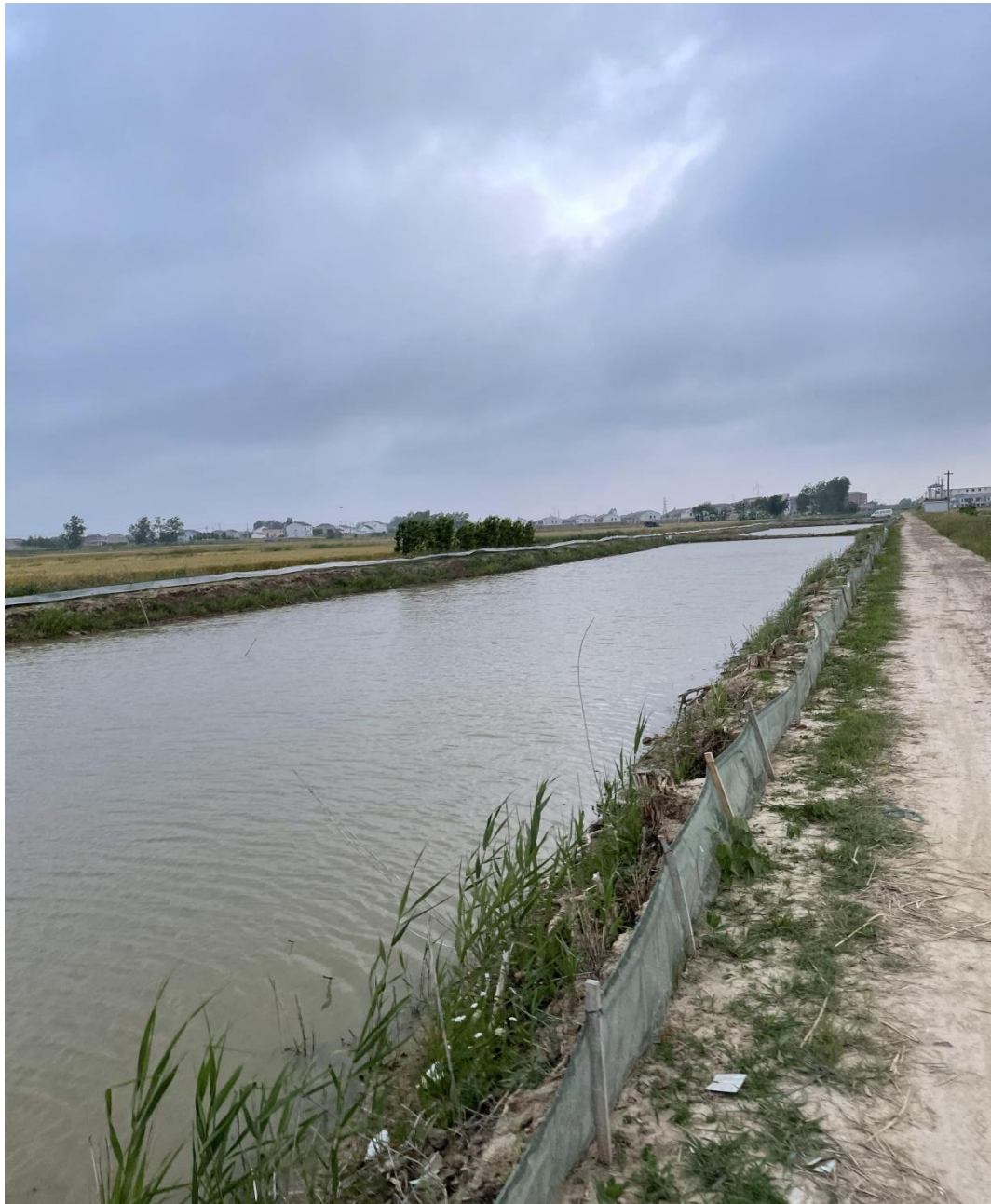
图 5.4-1 地块一内沟渠
