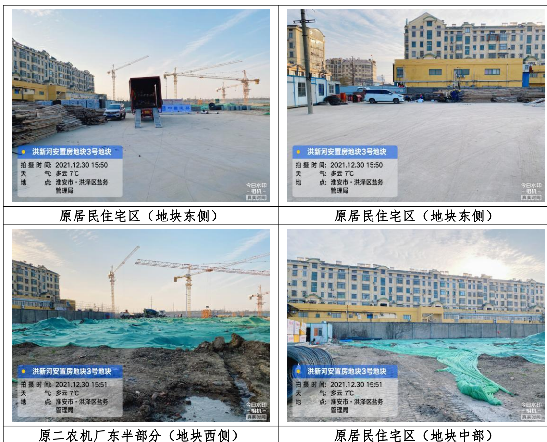
图 3.3.1-1 地块现状照片
