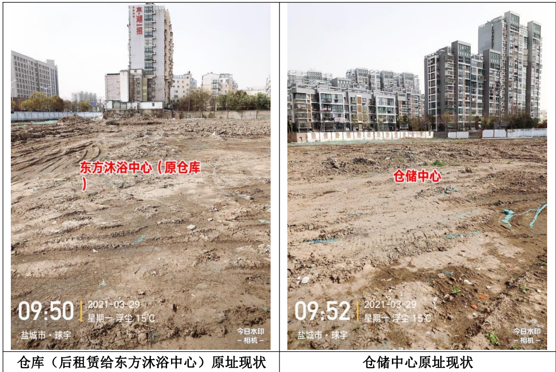
图 3.3-1 地块现状照片
